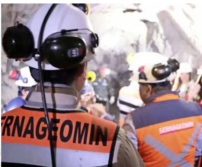
Personal de Sernageomin fiscaliza los sistemas de fortificación que se utilizan en las mineras.
